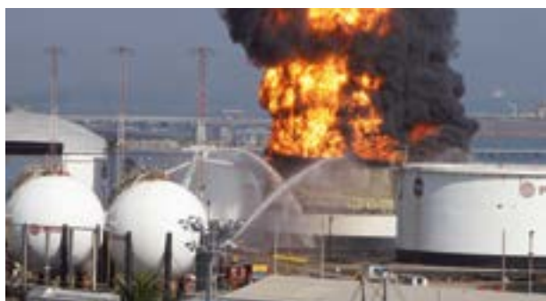
Incêndio em refinaria por queda de raio. Puerto Cabello (Venezuela).
